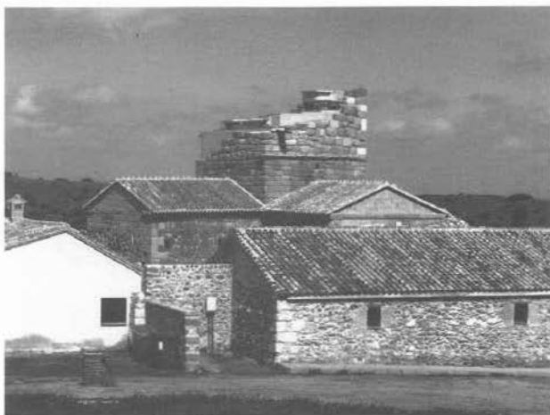
Fotografía III.- Vista del torreón restaurado y de los edificios construidos en el entorno de Santa María para explicar su historia a los visitantes.
