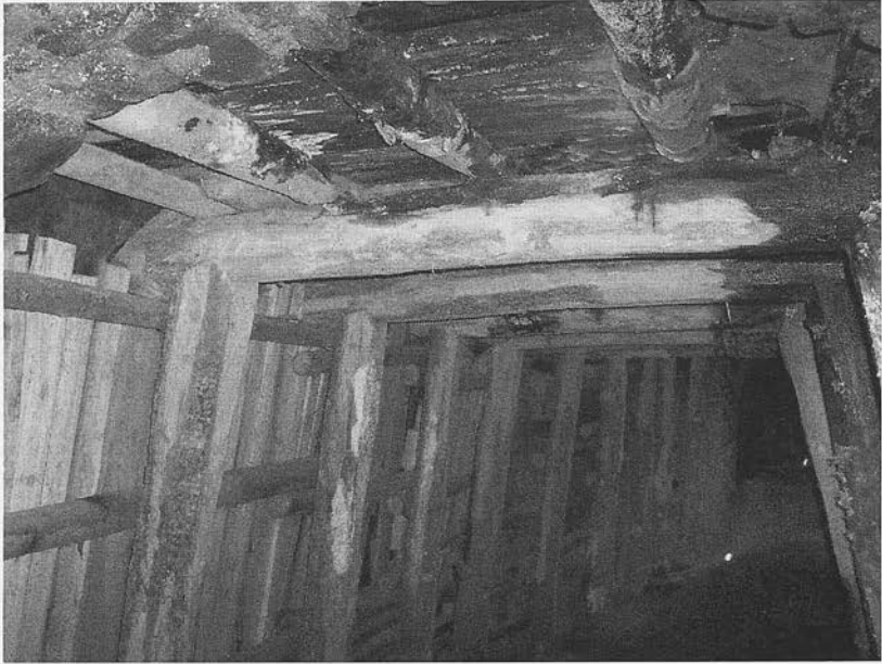
Figura 1.1. Enmaderado de una galería.
