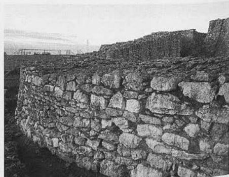
Imagen 5. Paramento exterior con mampuesto de gran tamaño.
