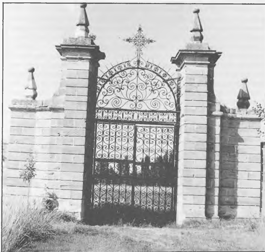
Puerta principal de la Obra del Obispo, hacia Poniente. (Fotografía: Martínez Gómez-Gordo, 1989)
