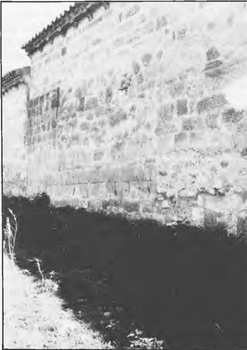
BAIDES. Pórtico desde el exterior.
