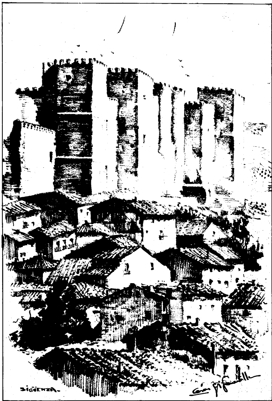
Lienzo de poniente, con la denominada «Torre de Doña Blanca» en el centro.
