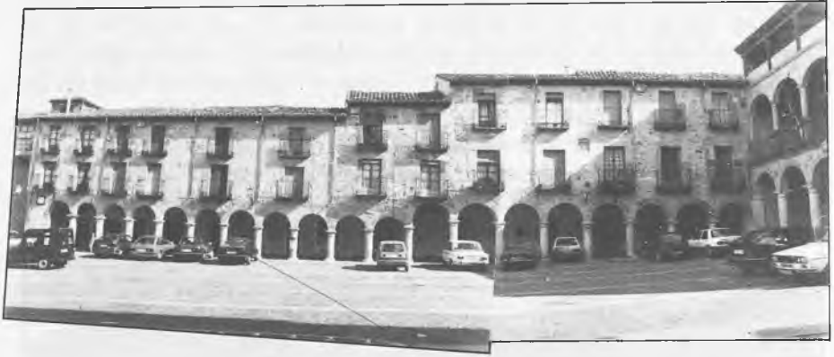
Fig. 8. Arcadas de la primera intervención en la Plaza de la Iglesia y de su ensanchamiento.
