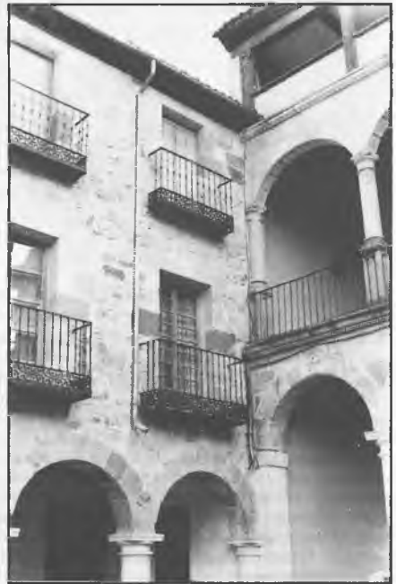
Fig. 9. Detalle de la forzada yuxtaposición de las casas de la Plaza a las galerías del actual Ayuntamiento.
