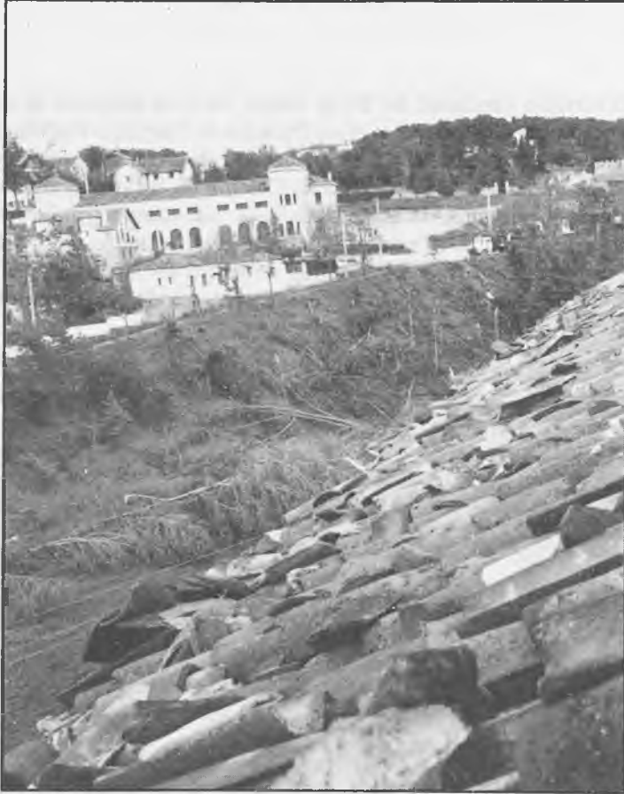
Cubiertas dañadas del Palacio de Infantes y al fondo todo el arbolado del Vadillo arrancado a cuajo
