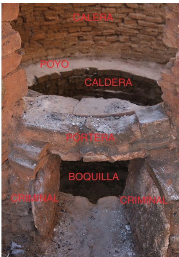
Detalle de una calera.
