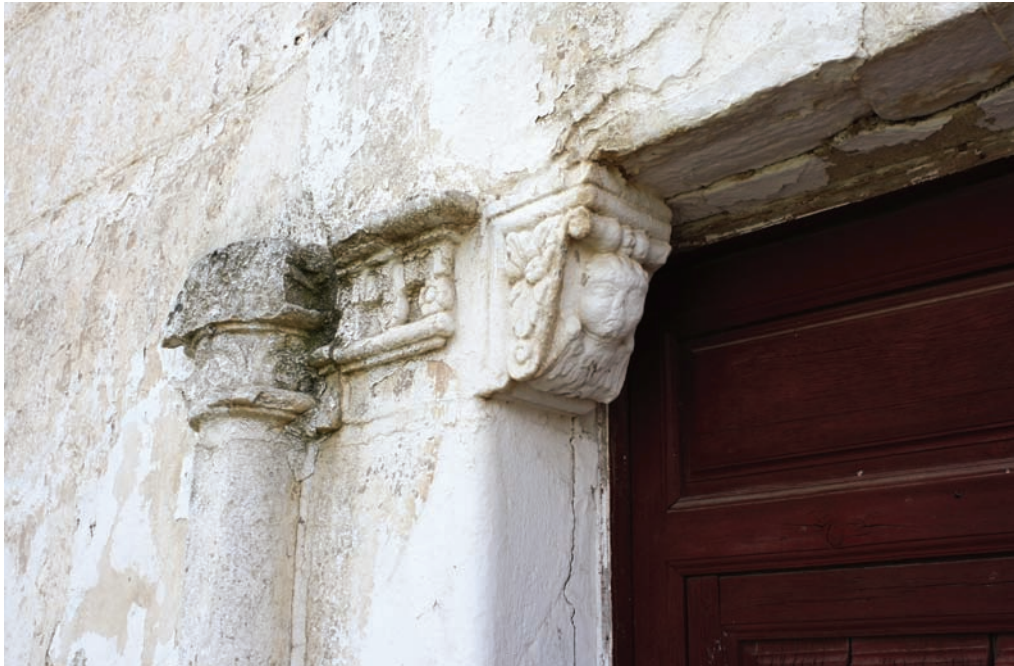
Venta de Borondo. Detalle portada principal, abril de 2011. Fotografía del autor.
