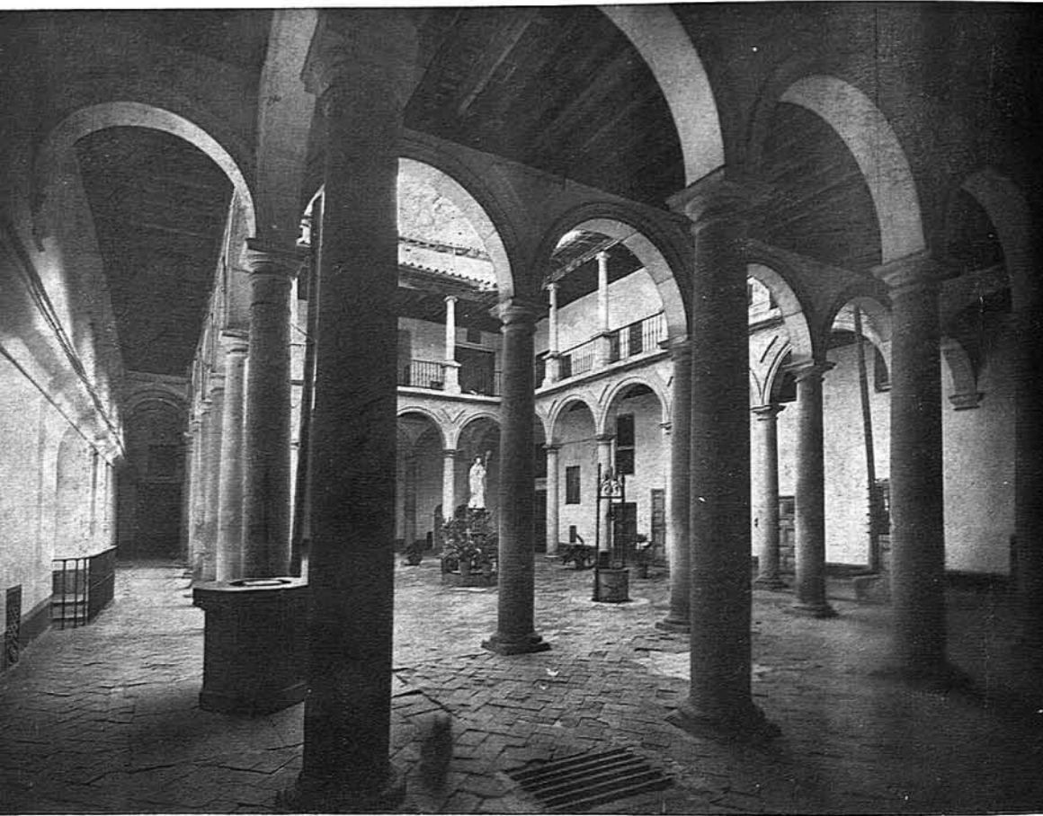
Vista general del Claustro del Refectorio del Monasterio de San Clemente, de Toledo
