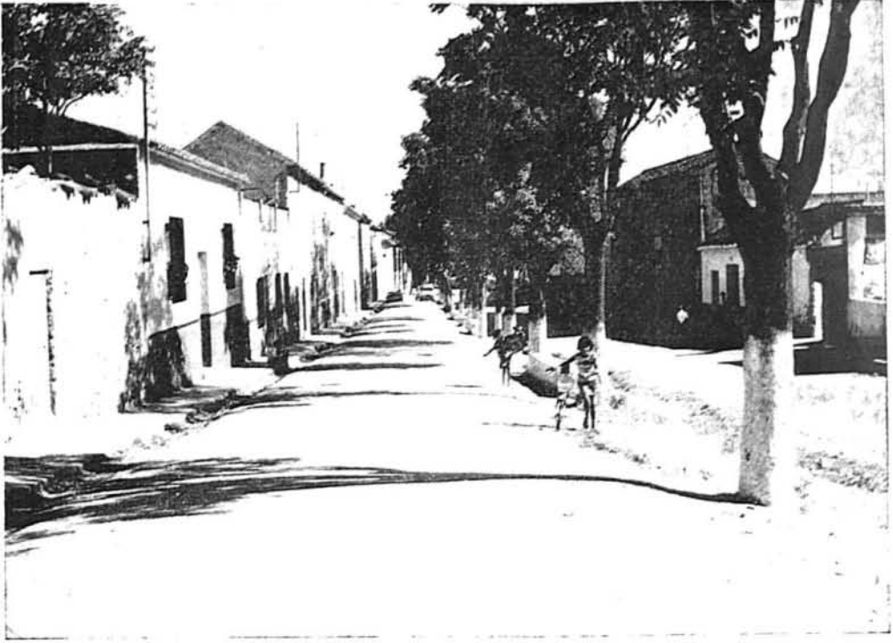
Pavimentación de la avenida de la Virgen de Gracia en Quero
