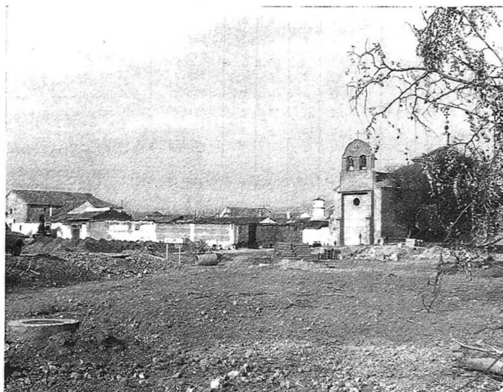
Dos aspectos de las obras de saneamiento en Villamiel
