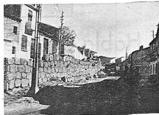
Restos de la antigua muralla de Oropesa
