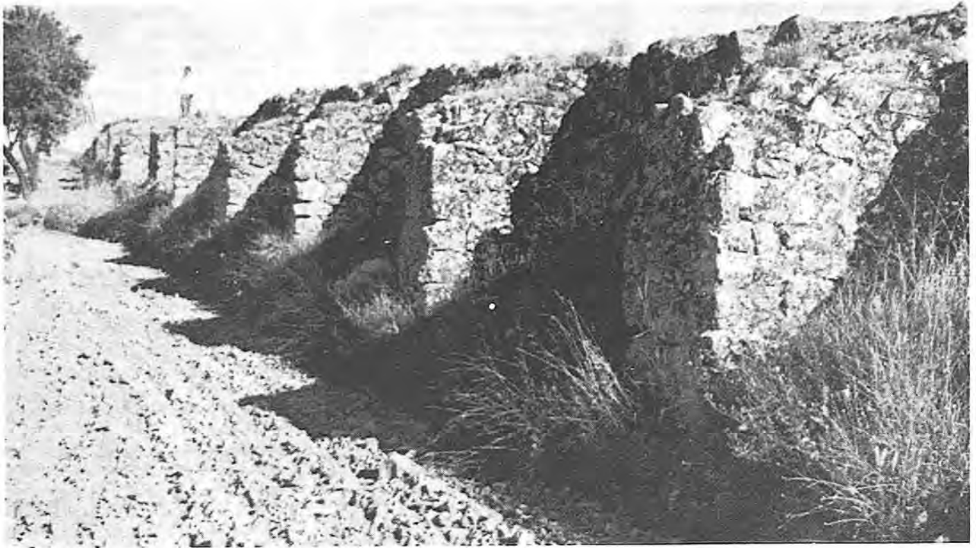
CONTRAFUERTE DE LA PRESA ROMANA DE CONSUEGRA TAL Y COMO SE CONSERVAN ACTUALMENTE
