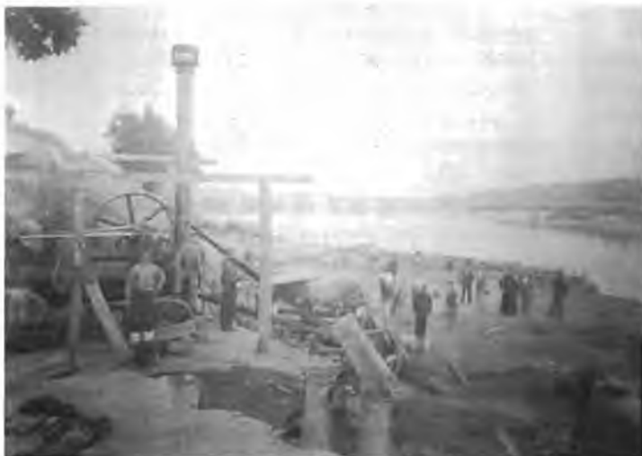
Foto 2.- Operarios y maquinaria en los inicios de las obras en 1904. (Foto Ruiz de Luna. Colección Consejería de Obras Públicas).
