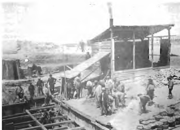
Foto 3.- Construcción del estribo de la margen izquierda, 1904. (Foto Ruiz de Luna. Colección Consejería de Obras Públicas).
