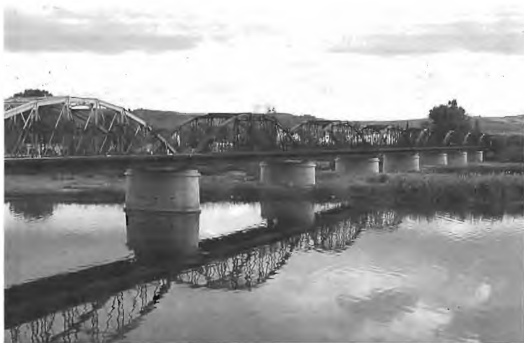
Foto 7.- Vista general del puente durante la remodelación de 1994. (Foto Alberto Moraleda).
