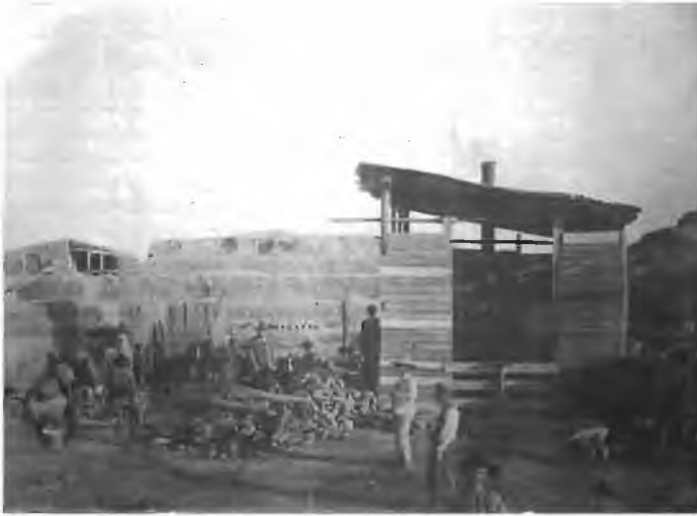
Foto 4.- Operarios e ingeniero durante las labores hacia 1905. (Foto Ruiz de Luna. Colección Consejería de Obras Públicas).
