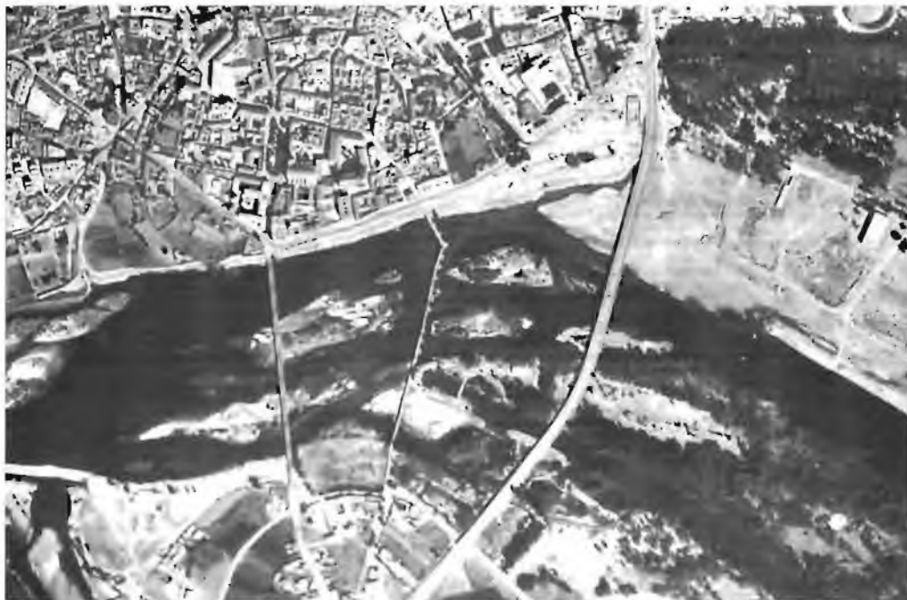
Foto 1.- Vista aérea de los 3 puentes sobre el Tajo a su paso por Talavera (Archivo A. Moraleda).
