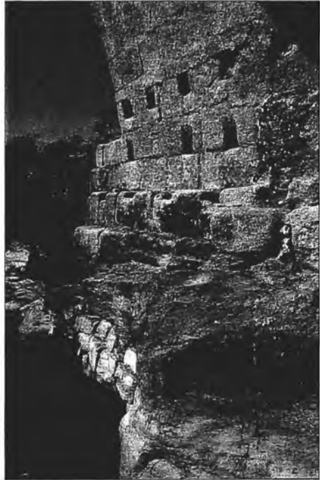
Fig. 5: Detalle de la base del estribo oeste del Puente de Cabeza del Conde. (Foto C. Pacheco).
