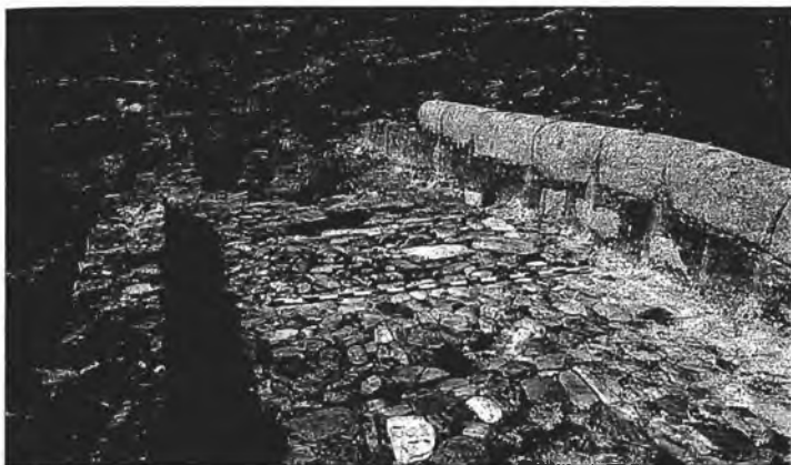
Fig. 2: Detalle de la calzada del Puente de Cabeza del Conde. (Foto C. Pacheco).
