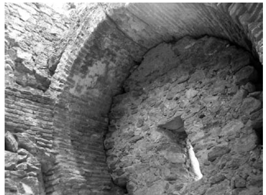
Fig. 5. Interior del piso inferior de la torre con vistas de la bóveda tumida (Imagen: D.G.P.)
