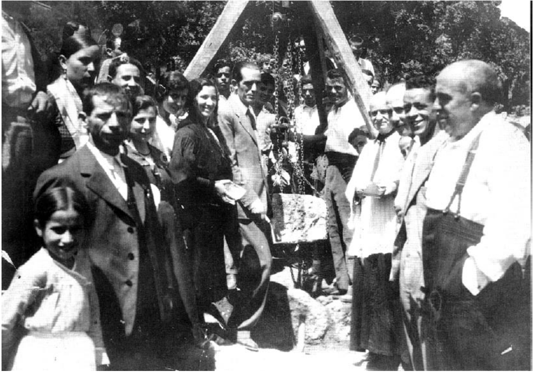
Fig. 2. Acto de colocación de la primera piedra de las escuelas el 25 de julio de 1934, festividad de Santiago Apóstol, marginando a la Corporación municipal candeledana, de mayoría radical-socialista, que había gestionado y pagaría la construcción de las Escuelas (Foto cedida por Luis Sánchez).
