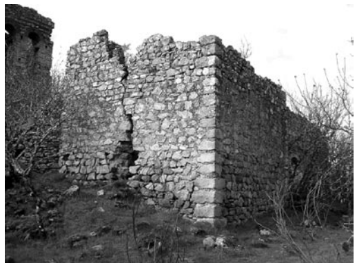
Fig. 8. Ampliación en la esquina noroeste de la iglesia, denominada “capilla o sacristía” (Imagen: D.G.P.)
