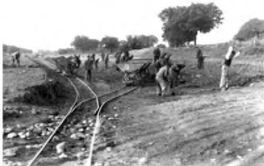
En la imagen puede verse a los preso de la brigada de tierra picando y las mulas tirado de la vagonetas sobre railes para transportar la tierra.
