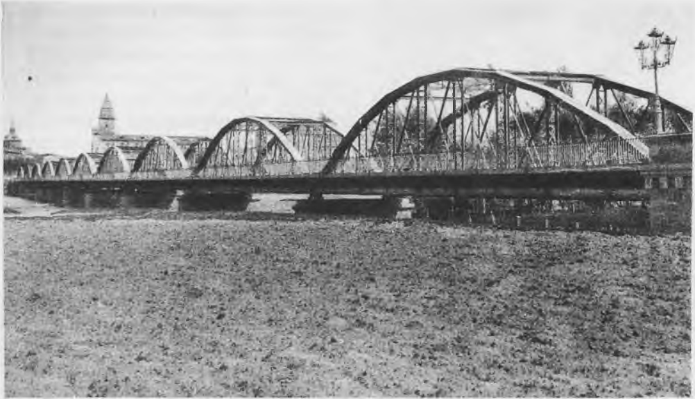
TALAVERA DE LA REINA. Puente metálico sobre el río Tago.
