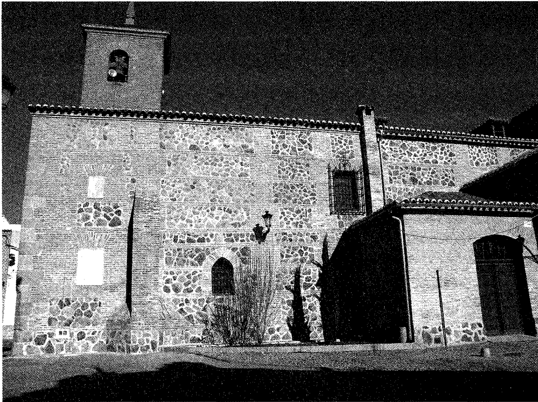
Fachada sur de la Iglesia.
