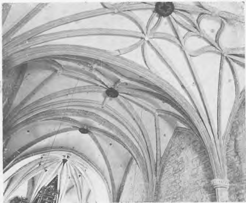
Detalle de las bóvedas.
