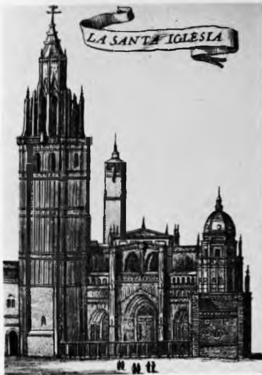
Fachada de la Catedral a fines del siglo XVII, con la segunda torre demolida hacia 1888, en la que estaban las campanas del reloj de Gutiérrez. Por falta de ellas éste sólo se oye desde el interior del templo.
