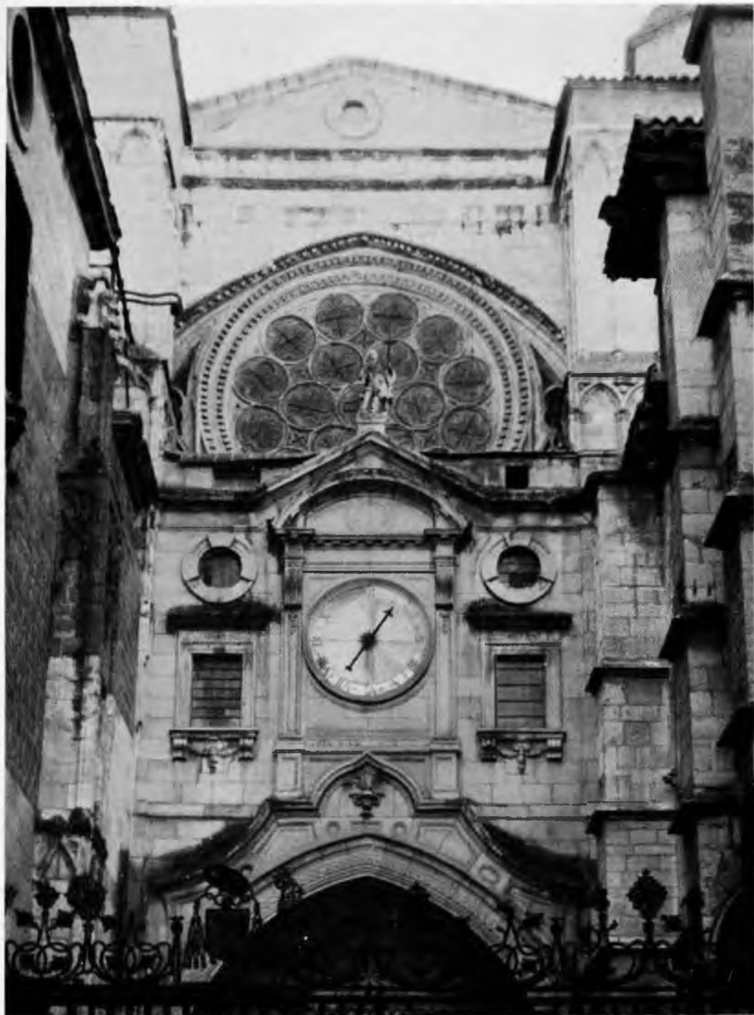
Fachada Puerta del Reloj. —El reloj sale al exterior por la Puerta de la Feria, llamada ahora también «Puerta del Reloj». Aunque el reloj interno señala minutos, tanto en esta esfera como en la de la nave interior de la Catedral, tiene sólo una aguja y señala la hora por su posición teórica entre cuartos.
