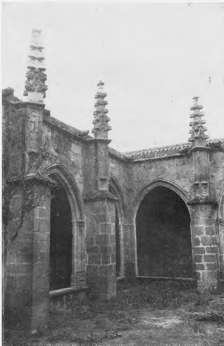
Lámina 15 Detalle interior del claustro
