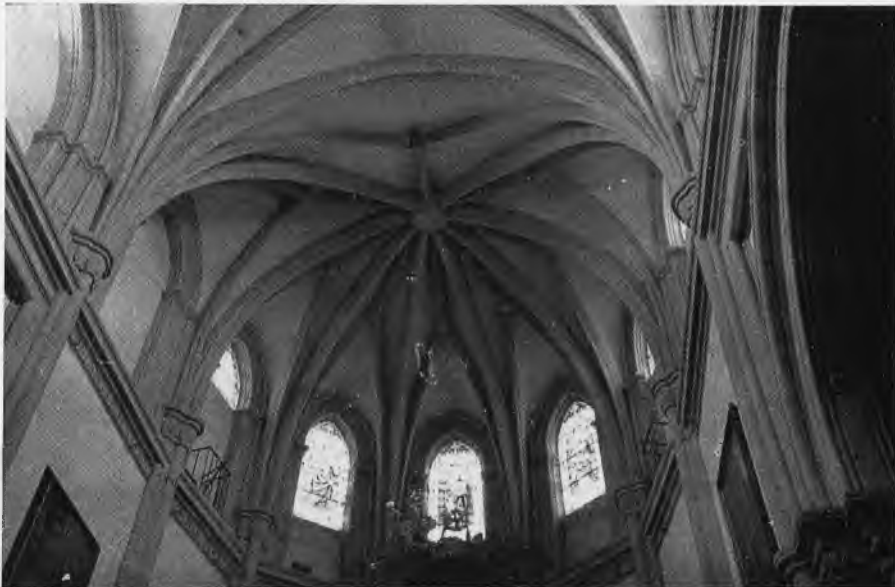
Bóveda de la Capilla Mayor
