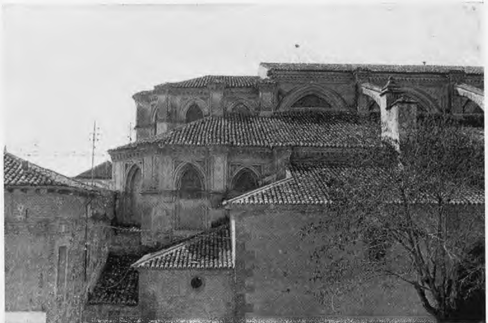
Abside del templo visto desde el lado norte. El edificio que aparece en el lado izquierdo parece ser el primitivo convento realizado por don Pedro Tenorio para que en él habitasen los canónigos
