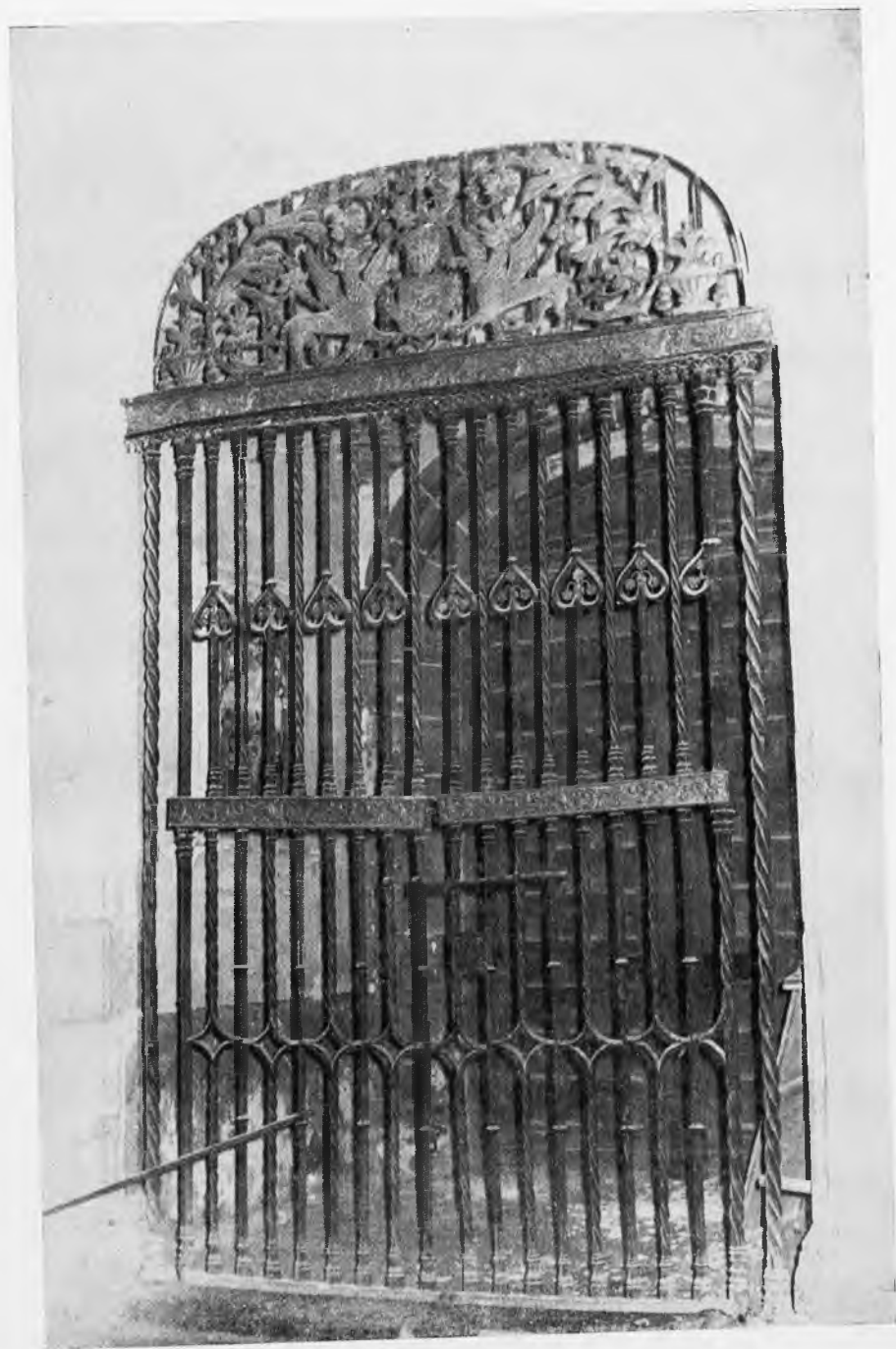
Lámina 41 Reja de la antigua Capilla Bautismal. Siglo XVI
