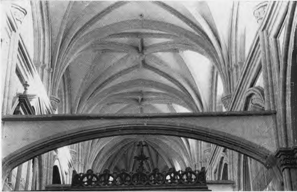
Bóvedas de la nave central
