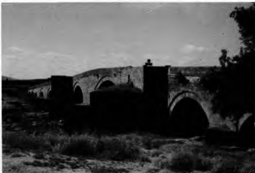
Puente sobre el Tajo. Puente del Arzobispo (Toledo).
