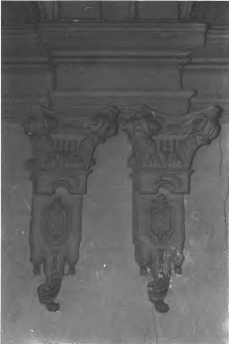
S. Pedro Mártir. Detalle de la decoración de yeserías del antiguo salón de actos
