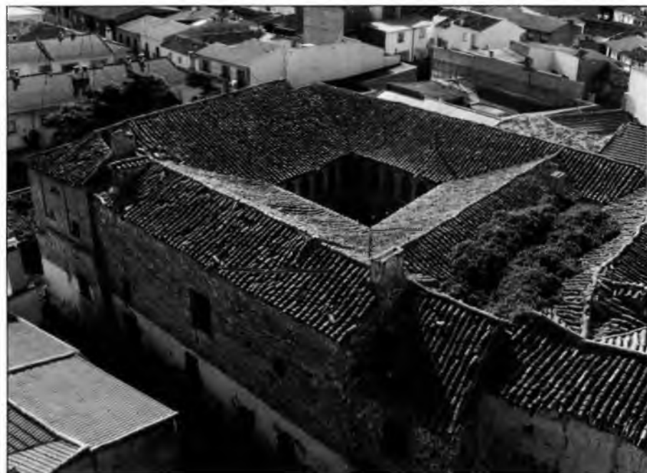
Fig. 27: La Casa de los Collado, fachada norte (fotografía aérea realizada por la empresa Sky Works).
