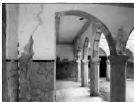
Fig. 21: Arco B-C y pilar encastrado en el muro, galería del Lado c (fotografía de Soledad Sánchez-Chiquito de la Rosa, op. cit., p. 66, Fig. 36).
