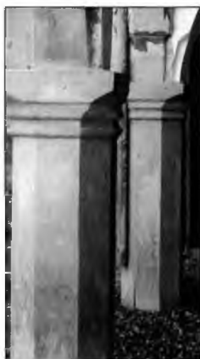
Fig. 11: Pilares octogonales (estado actual).
