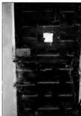
Fig. 59: Cara interna de una de las puertas de la fachada norte.
