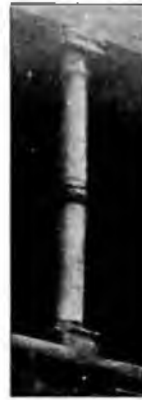
Fig. 29: Columna del piso superior, fotografía del Conde de Cedillo (1919).
