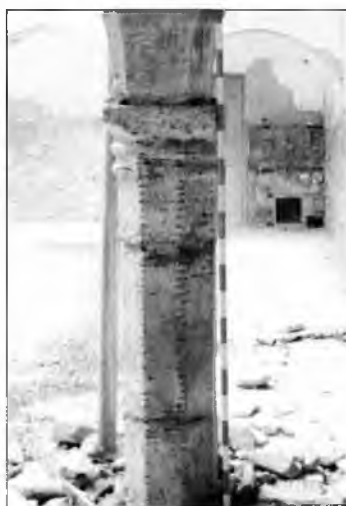
Fig. 12: Pilar sin el revestimiento actual (fotografía de Soledad Sánchez-Chiquito de la Rosa, Informe de los Trabajos Arqueológicos realizados en la Casa de los Collado de Corral de Almaguer en Toledo, junio 2005, p. 64, fig. 35).
