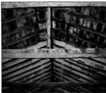
Fig. 51: Armadura de par y nudillo en el Lado b (crujía este) del piso superior (fotografía de Soledad Sánchez-Chiquito de la Rosa, op. cit., p. 73, Fig. 47).
