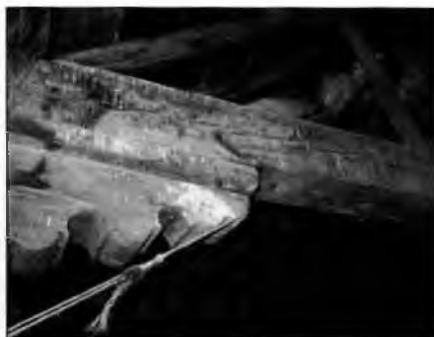
Fig. 55: Palomar con armadura de par y nudillo y tirante sobre can sin policromar.
