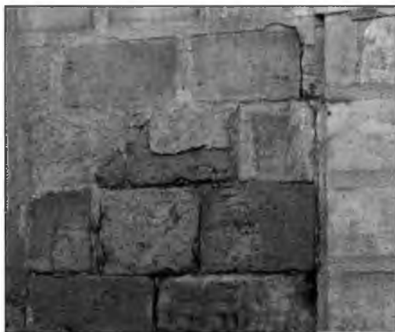
Fig. 7: Sillería en la antigua puerta principal.
