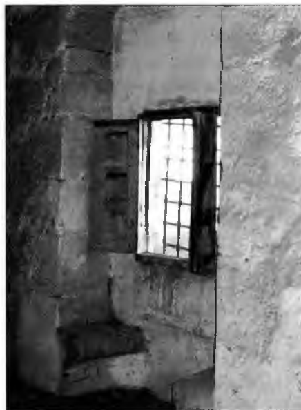
Fig. 41: Mirador en la sala principal del Lado a (crujía norte) en la planta superior.
