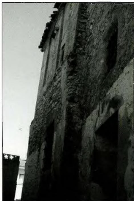
Fig. 8: Posible torre en el ángulo de las crujeías norte y este.
