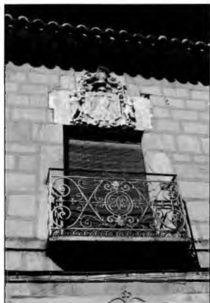
Fig 6: Escudo y arco sobre el dintel.
