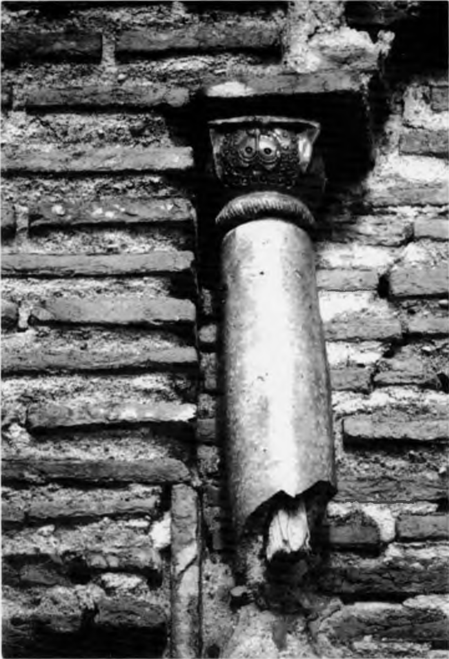
Fig. 3. Basa empleada como capitel. Ensamblaje mediante eje de madera y macizado de cal y arena. Vidriado verde.
