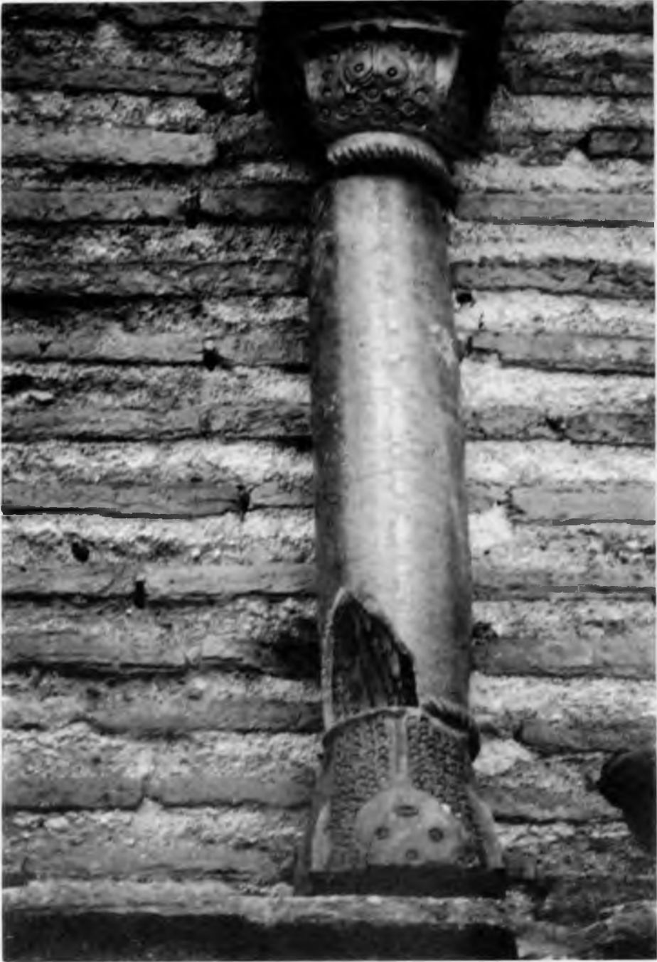
Fig. 4. Cupitel y basa, colocados de forma inversa y cubiertos con motivos de tipo zoomorfo, antropomorfo y geométrico. Ensamblaje realizado mediante eje de madera macizado de cal y arena. Vidriado verde.
