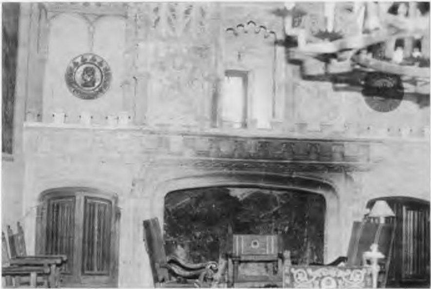
FOTO 29. La ventana de la foto 28 desde el interior.
