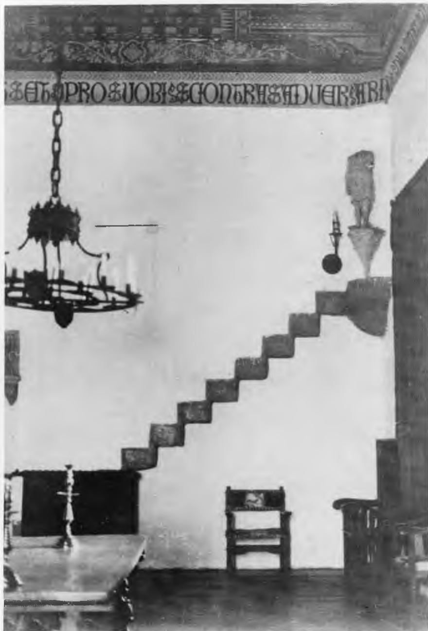
FOTO 27. Primer tramo de la escalera de la Torre del Homenaje desde la actual armería.
