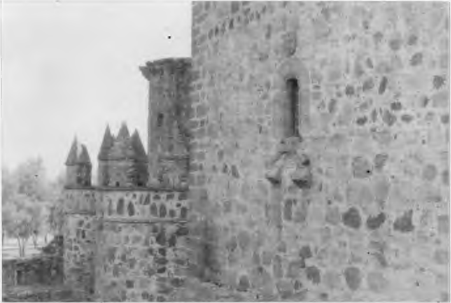
FOTO 28. Restos de los arcos del pasadizo volado.
