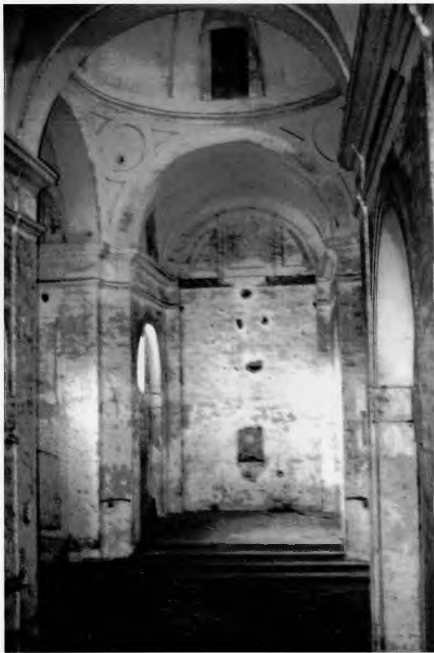
Fig. 7.—Convento de Velada. Interior hacia el testero
