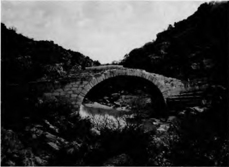
El antiguo puente sobre el río Uso
