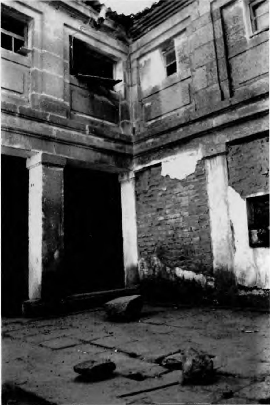
Fig. 5.—Convento de Velada. Patio
