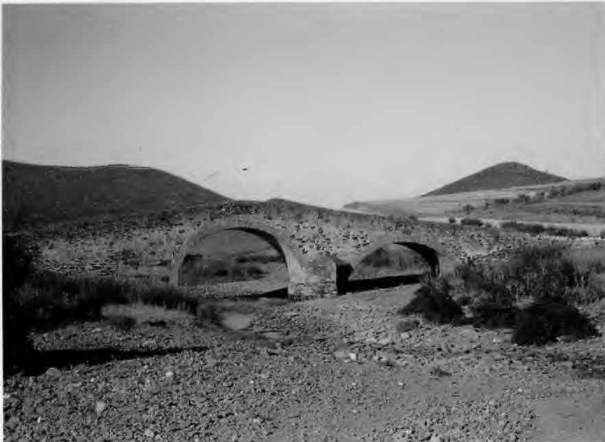
Puente sobre el Arroyo de la Andilucha (La Estrella)
