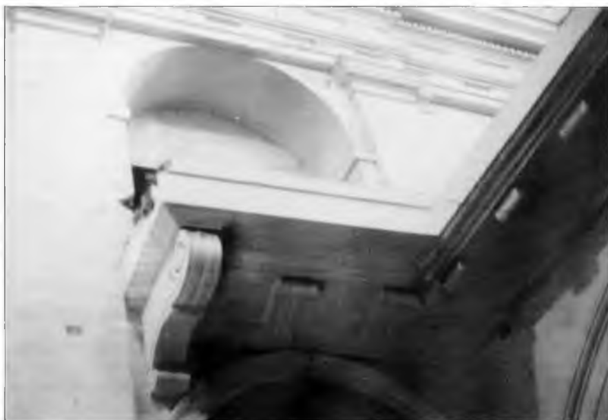
Lámina 7: Detalle del coro, antes de la rehabilitación.
