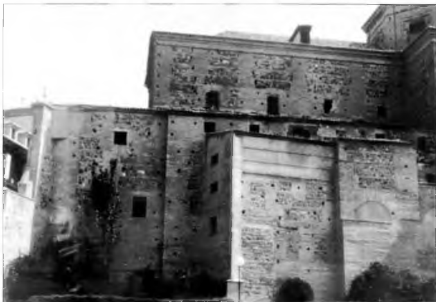
Lámina 1: Detalle del exterior; flanco suroccidental, antes de la rehabilitación.
