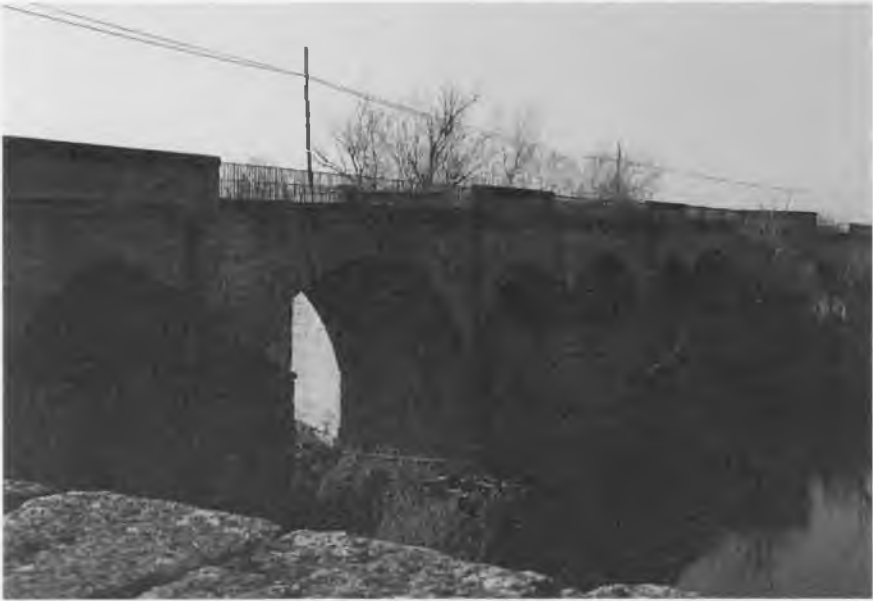
Aspecto general del puente de La Puebla.
