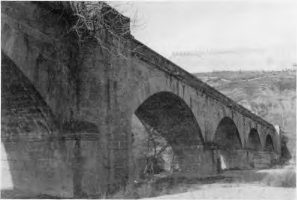
Escalona (Toledo). Puente sobre el río Alberche. c. 1992.
