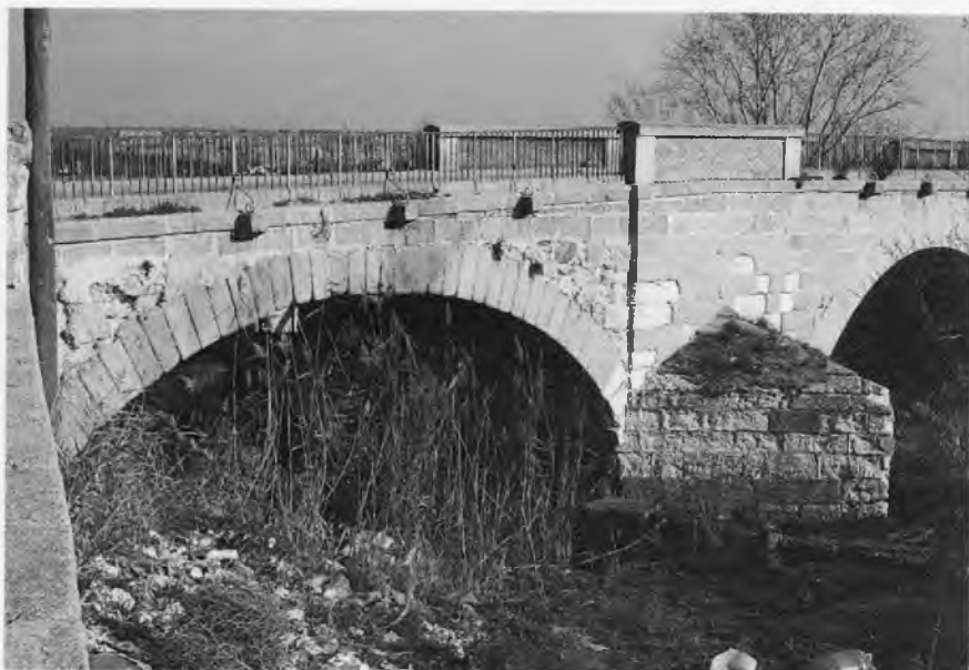
Arcos del puente y murallas.
