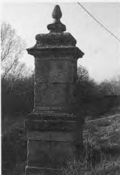
Pilar de entrada al puente de La Puebla
