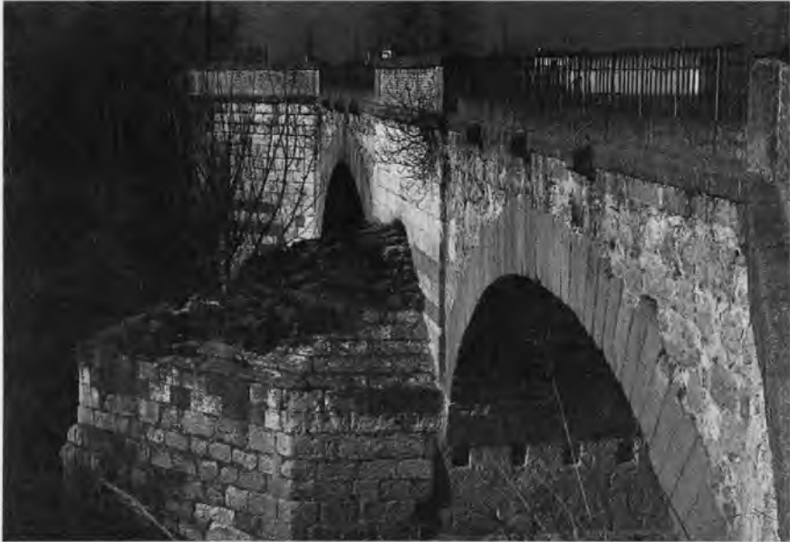
Arcos de un puente diferente, probablemente el último, añadido en distinta campaña constructiva.
