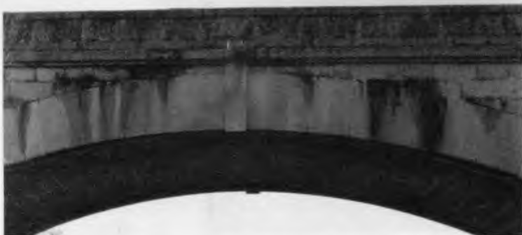
Escalona (Toledo). Puente sobre el río Alberche. c. 1992. Arco, desagüe y pretil.
