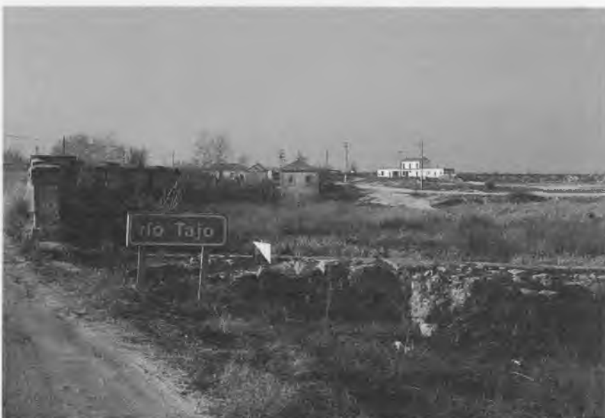
Entrada del puente desde La Puebla de Montalbán; a la izquierda, el pilón.
