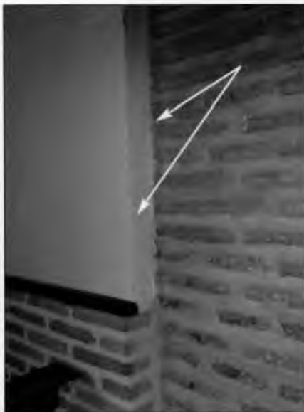
Desvíos en la conexión de la nueva obra del crucero con los pilares de la nave central.
