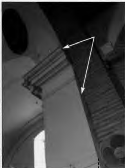
Desvíos en la conexión de la nueva obra del crucero con los pilares de la nave central.
