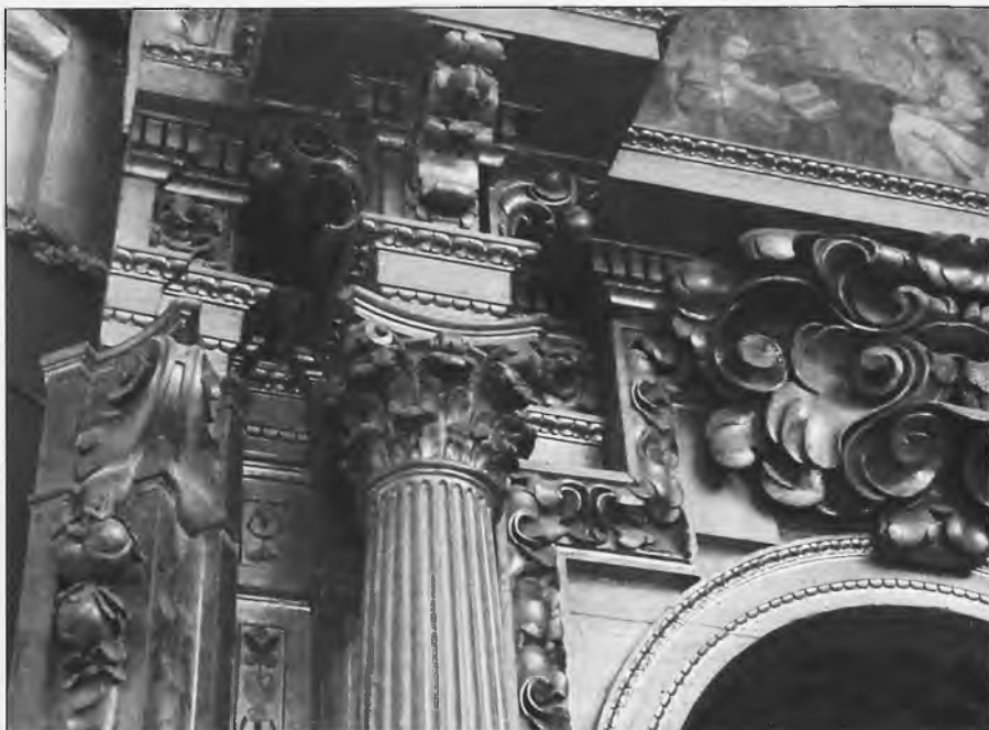
Fig. 2. Detalle del orden arquitectónico y ornamental.
