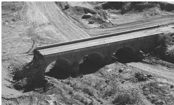
Figura 9. El “puente de las minetas” antes de su demolición. Fuente: Paisajes Españoles, 1982.
