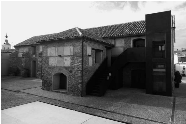
5. B. Vista general del edificio Cámara, antes y después de la intervención.
