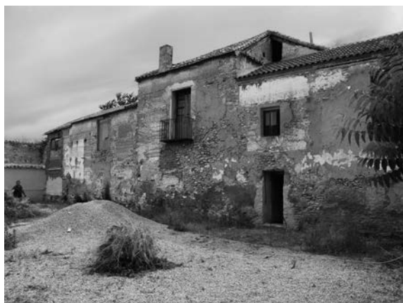
19 A. La medianera oriental del conjunto, antes y después de su restauración.
