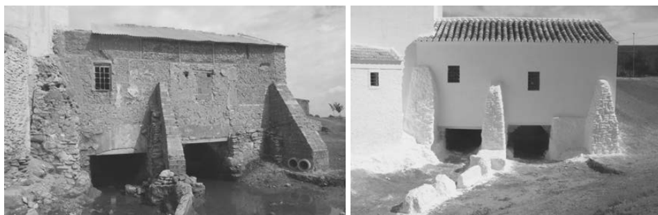
Imágenes 14 y 15. Molino de invierno, aguas abajo, antes y después de la intervención.
