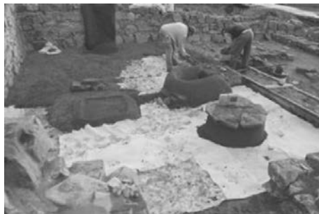
Figura 14: Colocación de la grava sobre el geotextil; último paso en la consolidación y restauración del edificio. Foto GICC.
