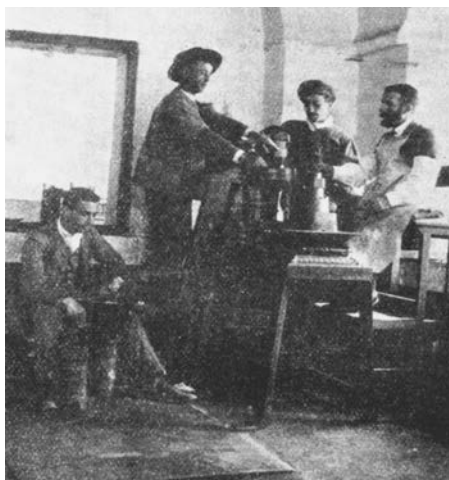
Figura 1: Envasado de azogue en frascos de hierro, año 1920 5 .
