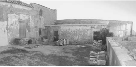
Imagen 16. Patio antes de la intervención.
