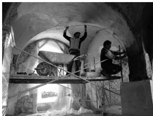
13. Trabajos de consolidación de las bóvedas de la planta baja de la Cámara.
