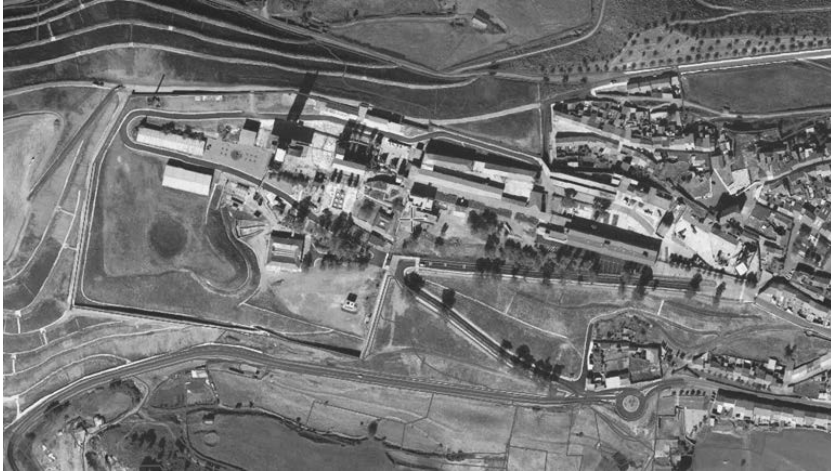
Figura1: Estado actual del Parque Minero de Almadén. Fuente: http://www.sigpac .
