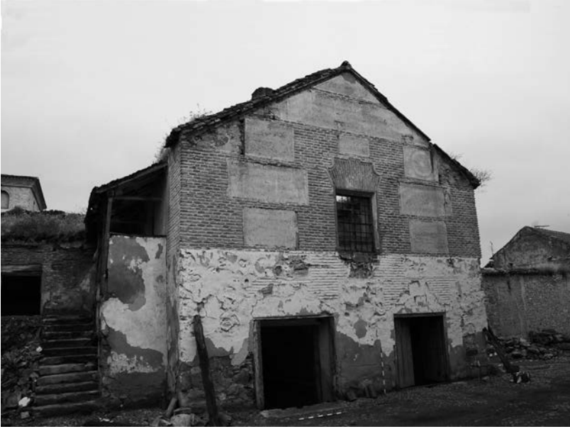
7 A. La fachada norte de la Cámara, antes y después de la intervención.
