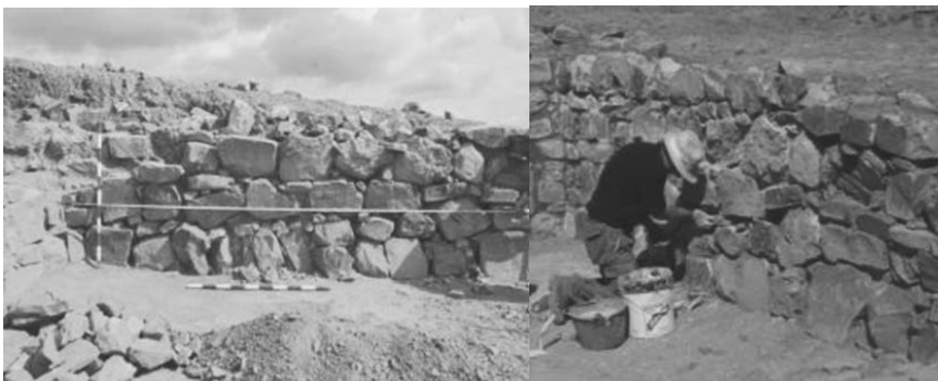
Figuras 10 y 11. Documentación previa y trabajos de consolidación de la estructura ya reconstruida.
