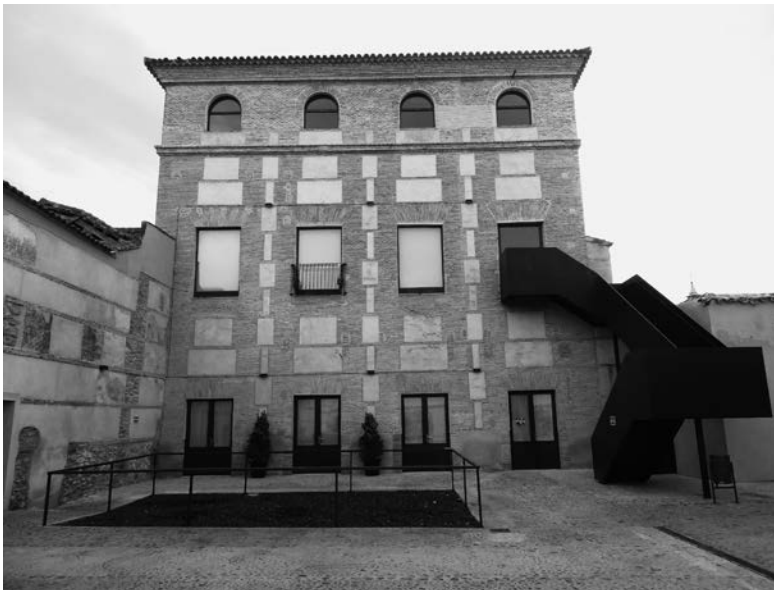
4. Fachada norte del edificio principal o Torreón, una vez finalizados los trabajos.
