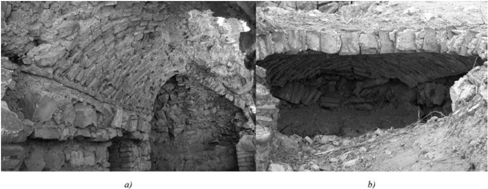
Fig. 7.- Restos de bóvedas de ladrillo con rosca “a bofetón” en el antiguo espacio conocido como “casa de los pavones”. (Foto autor).
