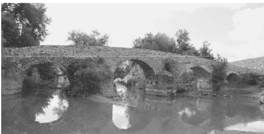
Figura 1. Estado actual del Puente de las Ovejas, termino municipal de Corral de Calatrava.
