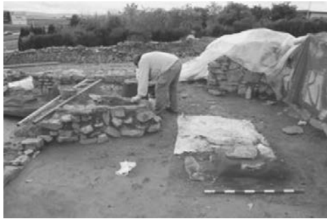
Figura 13: Encapsulamiento de hogares y otras estructuras. Foto GICC.
