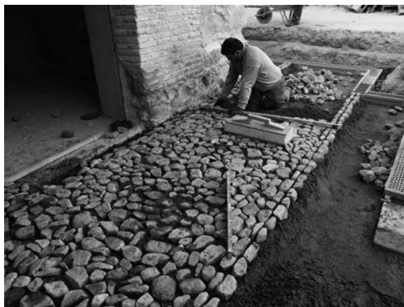
17. Reparación de los pavimentos empedrados del patio junto a la fachada oriental de la Cámara.
