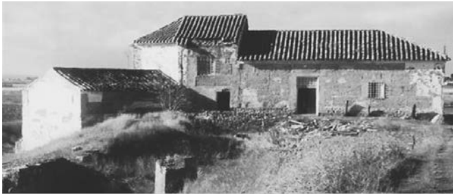
Imagen 10. Año 2003, después de la limpieza y desescombro. (Foto: Memoria de Actuaciones ACWA-SEM 2002).
