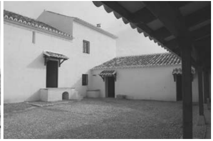
Imagen 17. Patio después de la intervención.
