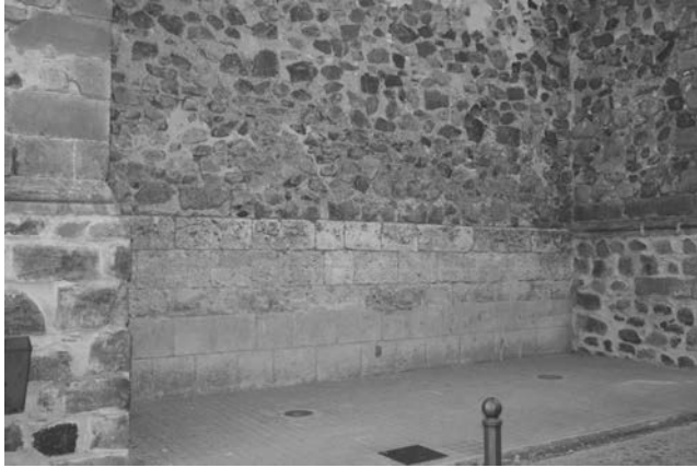
Figura 2: Sillares del muro del lado de la epístola.
