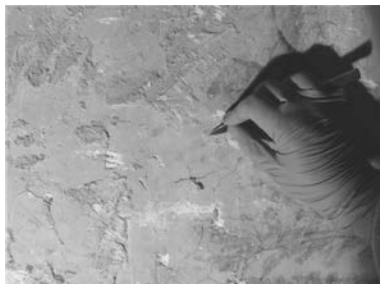
1. Detalle del proceso de restauración: limpieza mecánica.
