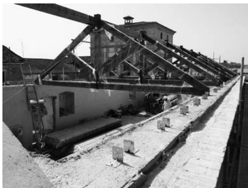
14. Proceso de reconstrucción de la estructura de cubierta de la Cámara.
