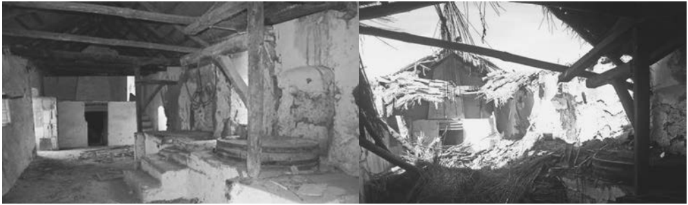
Imágenes 3 y 4. Vista del interior de la sala de molienda en 2010 y en 2014.
