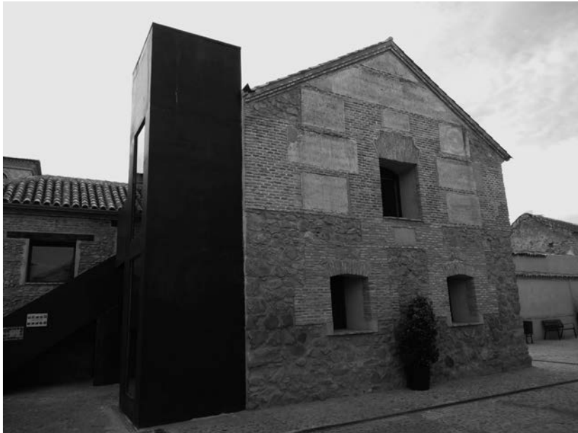
7 B. La fachada norte de la Cámara, antes y después de la intervención.
