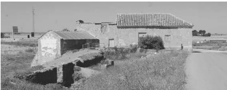
Imagen 12. Molino Grande antes de la primera fase de obras de restauración.
