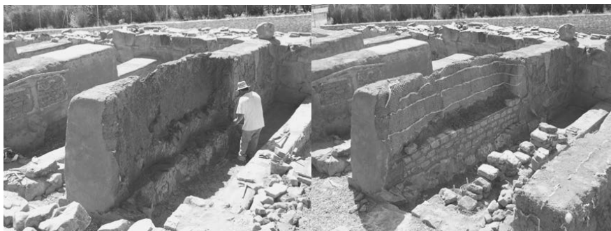
Figuras 4 y 5: Proceso de consolidación y restauración del interior del bastión de la Muralla Sur. Foto GICC.
