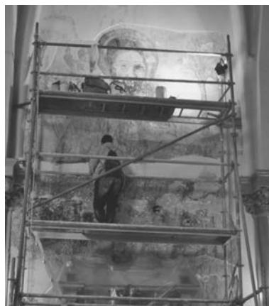
2. Vista general del Muro Norte, interior de la Iglesia San Andrés, durante la restauración.
