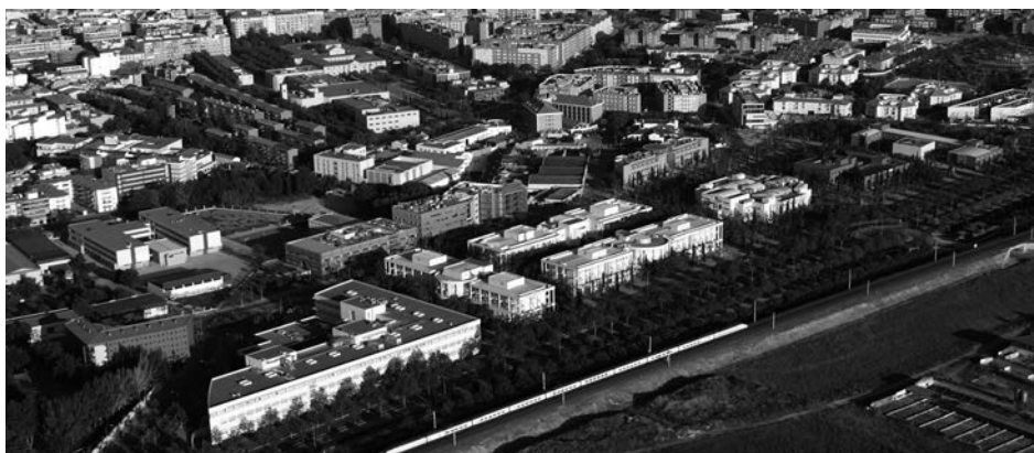
4. Vista aérea del Campus Universitario
