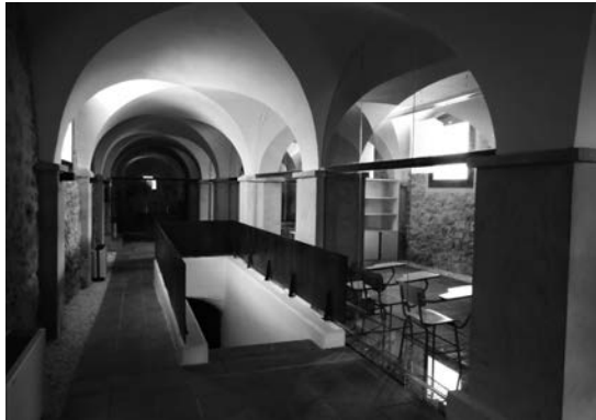
15. B. El interior de la planta baja de la Cámara, antes y después de la eliminación de las compartimentaciones de mediados del siglo XX.
