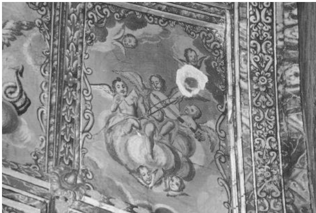
Ilustración 12: bóveda. Pintura al fresco. Detalle. Foto autor.
