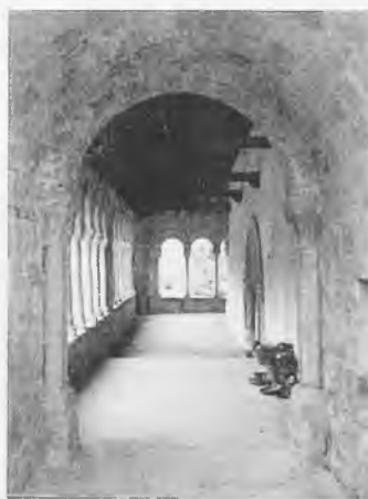
Fig. 3. Vista de la panda sur del pórtico desde el interior. Foto autor.
