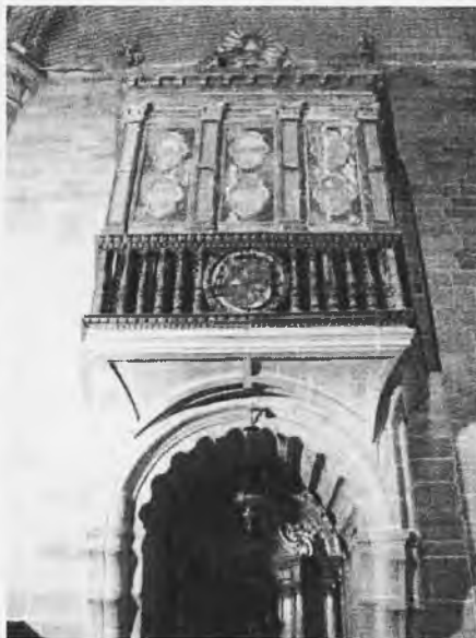
Espalda del órgano a la nave lateral
