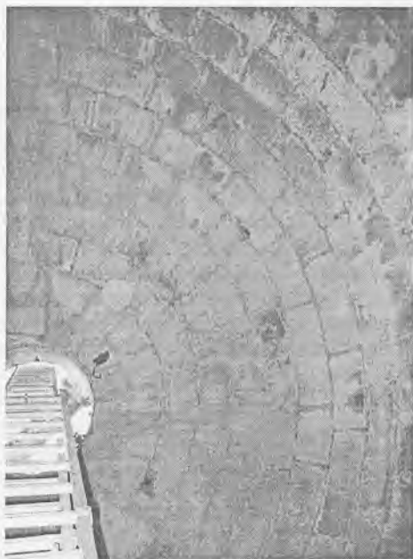
Fig. 14.- Fotografía de la bóveda interior del aljibe, en el Claustro (foto de José Juste).
