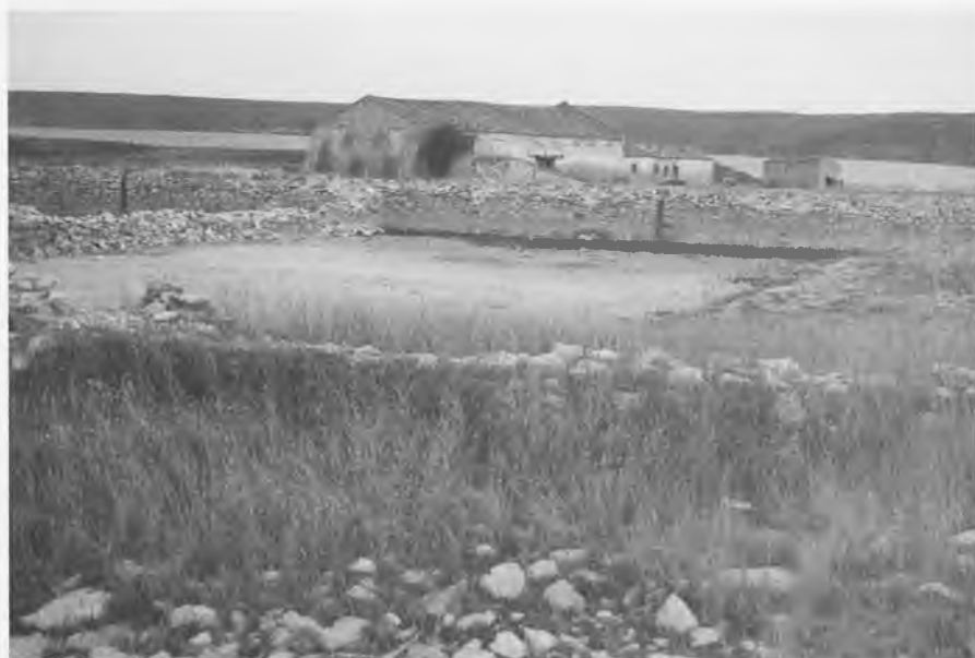
Lám. V: Recocedero y almacenes de la salina "La Verdad" de Bujalcayado. Todavía en aceptable estado de conservación.
