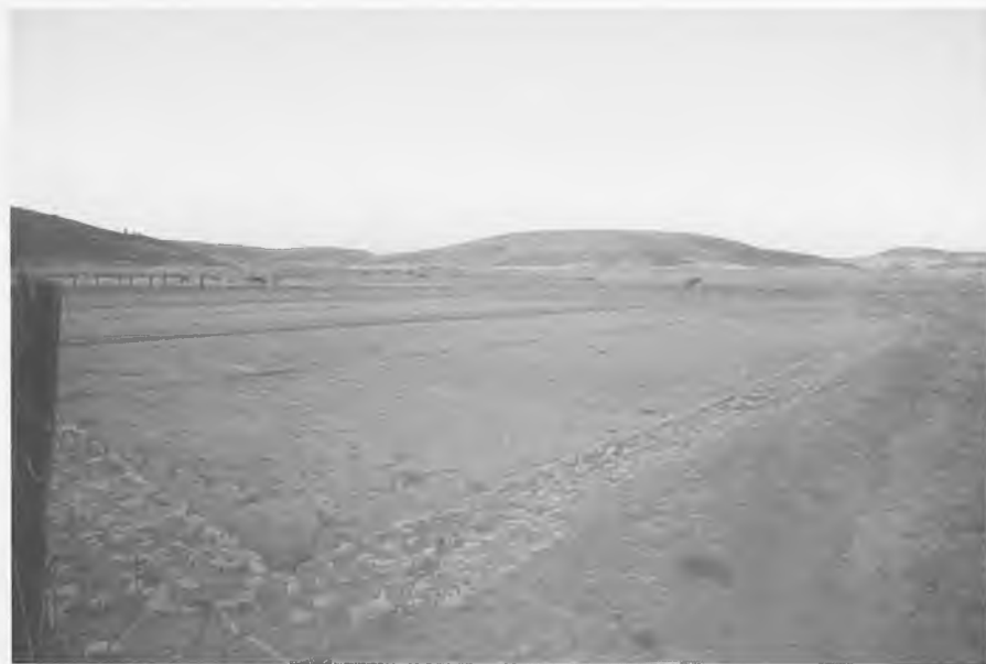
Lám. IX: Detalle de las instalaciones de las salinas de Cirueches, como puede observarse en relativo buen estado de conservación.
