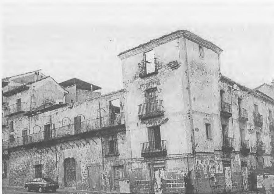
Estado en que quedó la Casa de la Tesorería tras el incendio
