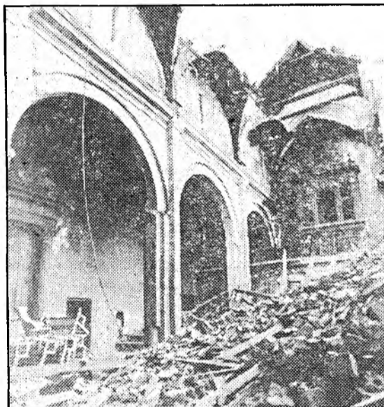
LA IGLESIA CORDOBESA DE SANTIAGO, REDUCIDA A ESCOMBROS. — La techumbre de la iglesia de Santiago Apóstol, de Córdoba, se derrumbó completamente, quedando el templo convertido en una ruina. En dicha iglesia trabajaban 12 obreros en tareas de reparaciones, pero en el momento de producirse el derrumbamiento no se encontraban en sus puestos, lo que salvó sus vidas. La iglesia estaba siendo reparada tras haber sufrido un violento incendio el 20 de diciembre del año pasado. Esta vez los daños son cuantiosísimos, ya que ha quedado prácticamente destruida.
