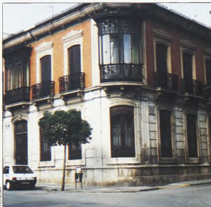
La Casa de los Izarra fue construida en 1900
