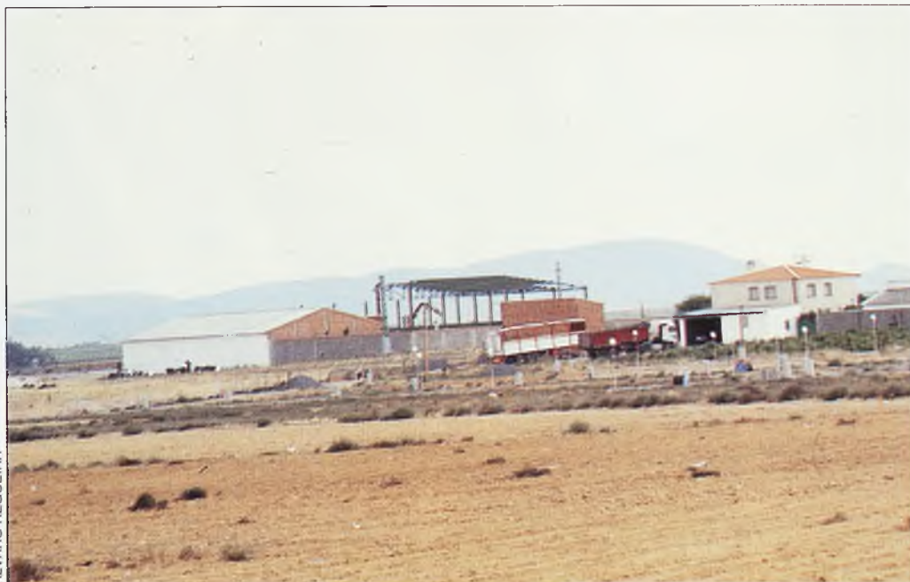
Las construcciones realizadas por José Nieves en los terrenos destinados al futuro polígono industrial desató la guerra entre el ayuntamiento y el constructor durante 1993.
