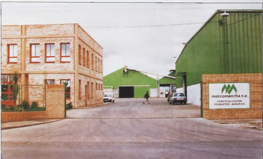
Las modernas instalaciones de MERCOMANCHA han supuesto una inversión de 300 millones
