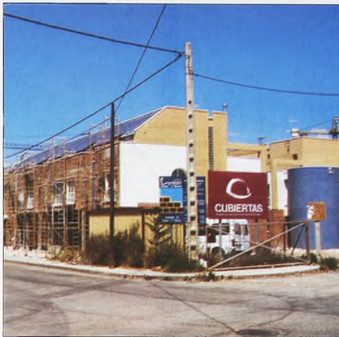
Estas son parte de las 111 viviendas que se construyen para ellos en Pío XII.
