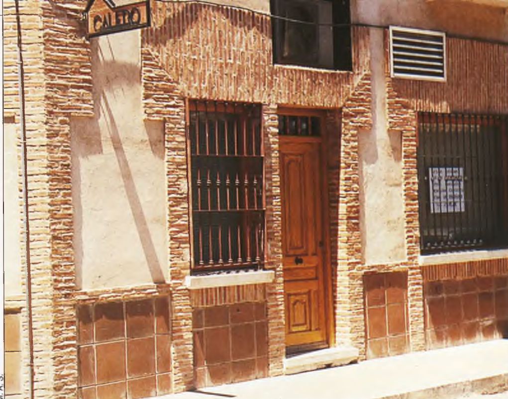
La empresa CALFER, propiedad de Calero Fernández, ha dejado deudas a la Caja de Castilla La Mancha, Strugón y numerosos propietarios
