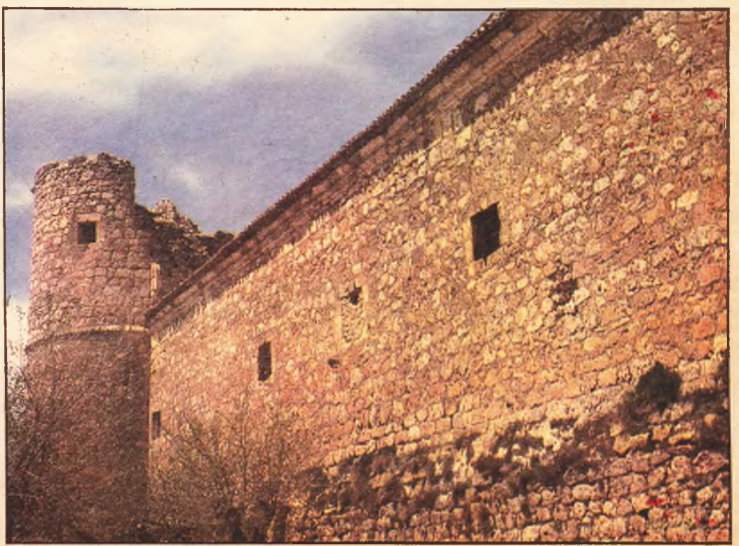
Barbacanas caídas, muros descarnados, ruina progresiva, que aún podría detenerse
