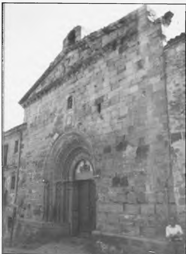
Santiago. Fachada occidental
