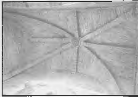
Bóveda del presbiterio.
