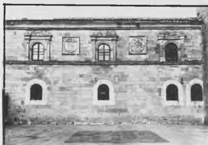
Edificio de la Contaduría, construido en el pontificado de D. Fadrique de Portugal
