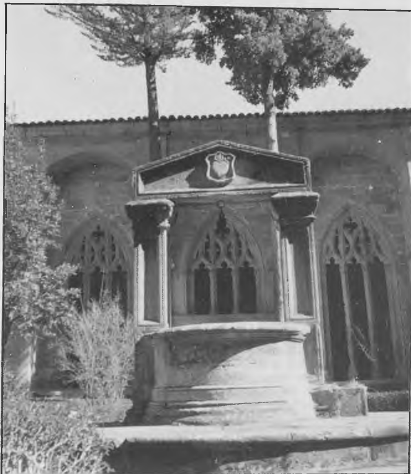
Brocal del pozo y ventanales de la panda este
