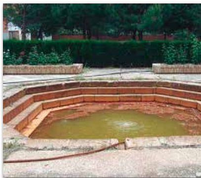
Figura 15. Balneario de Villar del Pozo. Detalle del hervidero.
