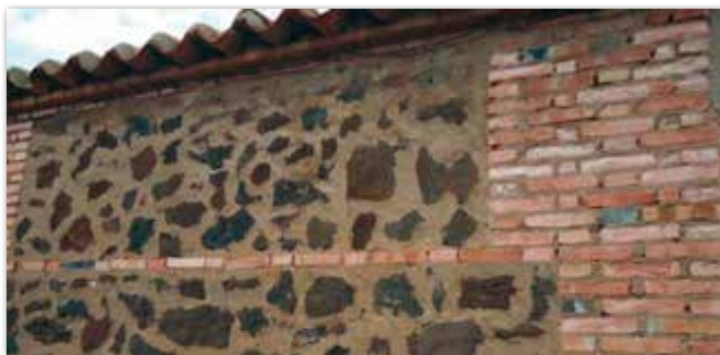
Figura 27. Detalle del muro norte de la Iglesia Visitación de Nuestra Señora.
