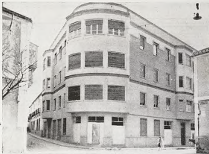
De cómo es posible construir mucho y bien dentro del casco urbano, lo demuestra el edificio que acaba de terminar la Cámara Oficial de la Propiedad Urbana, en las calles de General Rey y Palma.
