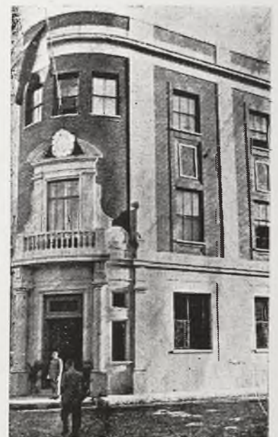
Edificio de Teléfonos
