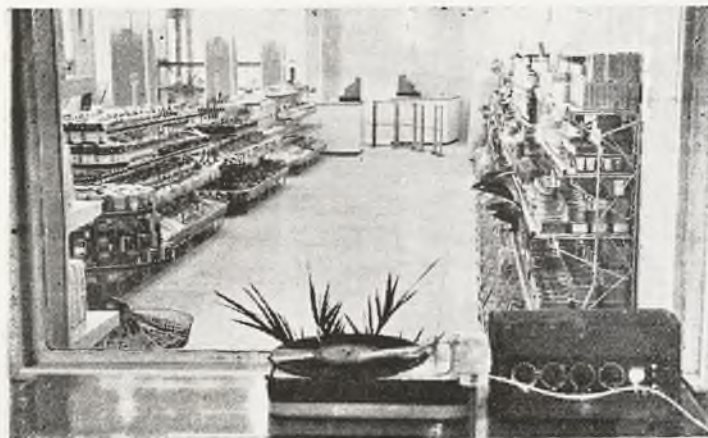
Una vista parcial de las instalaciones del Auto-Servicio de la Mancha, en una de las amplias naves del Mercado de Abastos.
