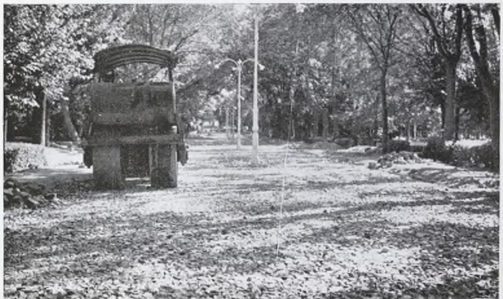
Estado de las obras de pavimentación de uno de los paseos que están siendo asfaltados.
