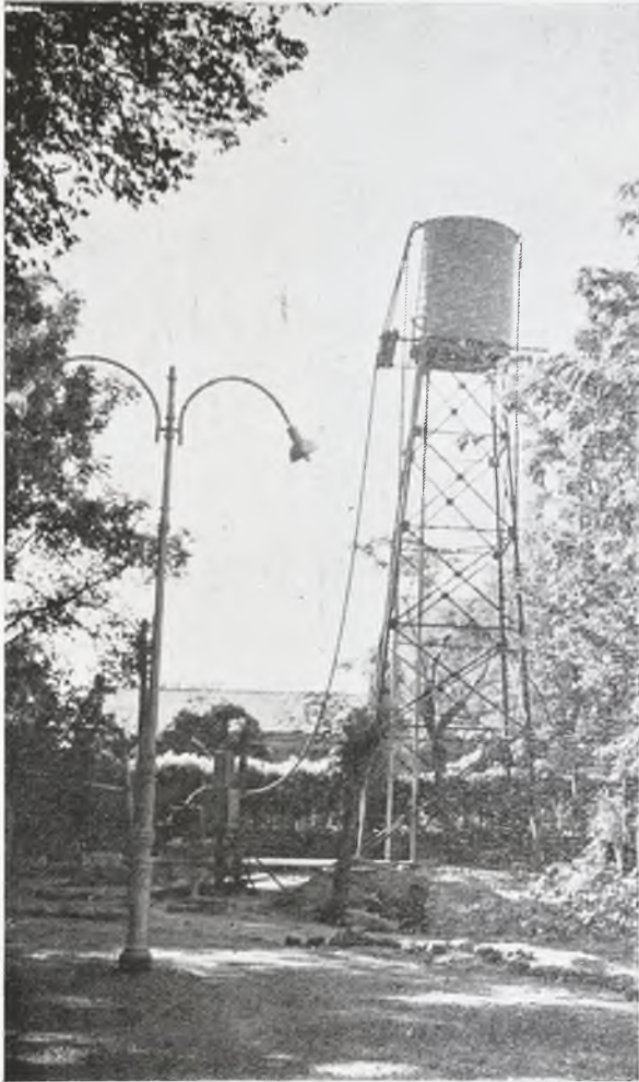
Nuevo depósito de agua instalado en el Parque para el riego de los jardines, y en primer plano, una de las elegantes columnas que adornan e iluminan todo el recinto.
