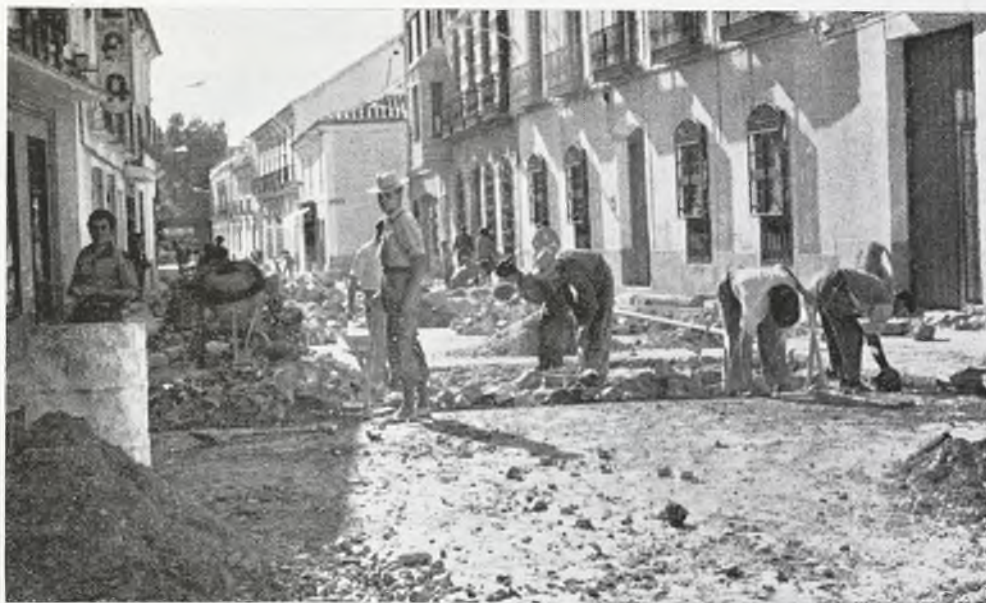
Obras de pavimentación de la calle Ramón y Cajal, que están a punto de terminar.
