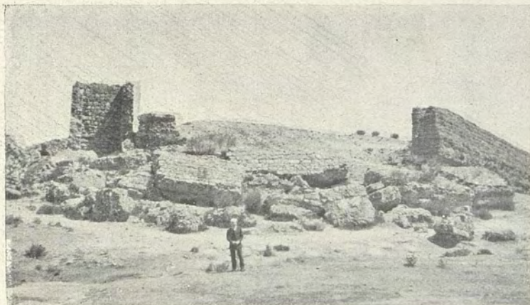
1. Presa de la Alcantarilla (Toledo)
