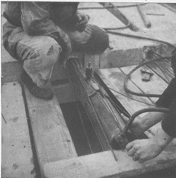
Fig. 26.—Anclaje de los hierros con presillas y estirado aplicando presión a la cámara 1.
