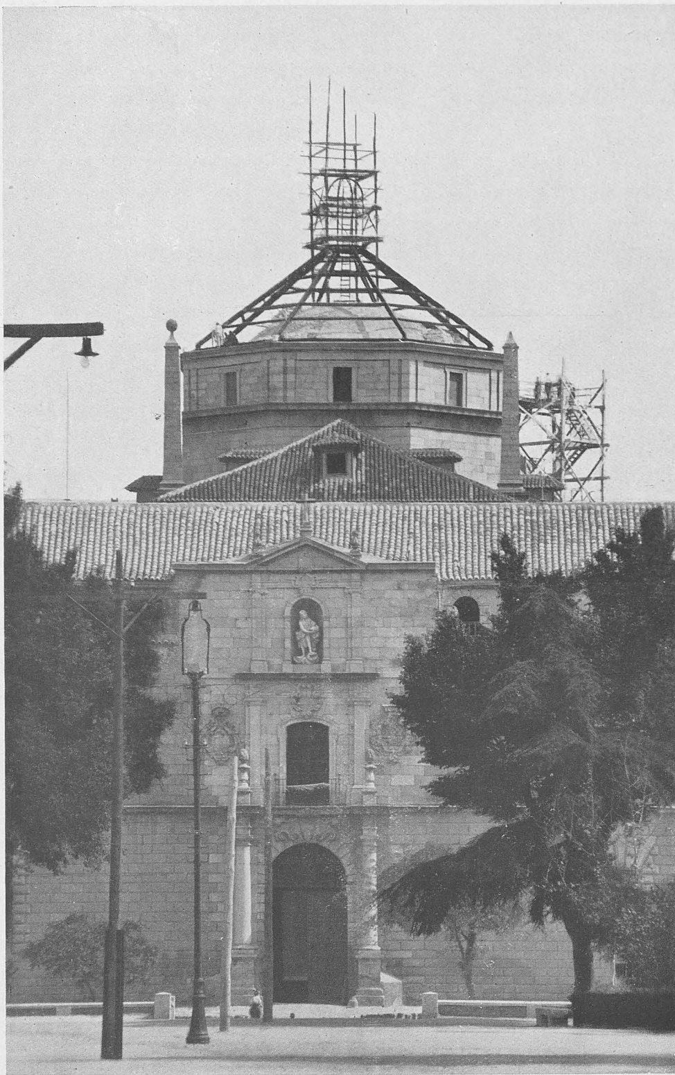
TOLEDO.—Hospital de Afuera, durante las obras de reconstrucción.
